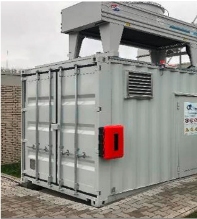
Aufbau des Druckluftheizkraftwerkes in der Kläranlage
