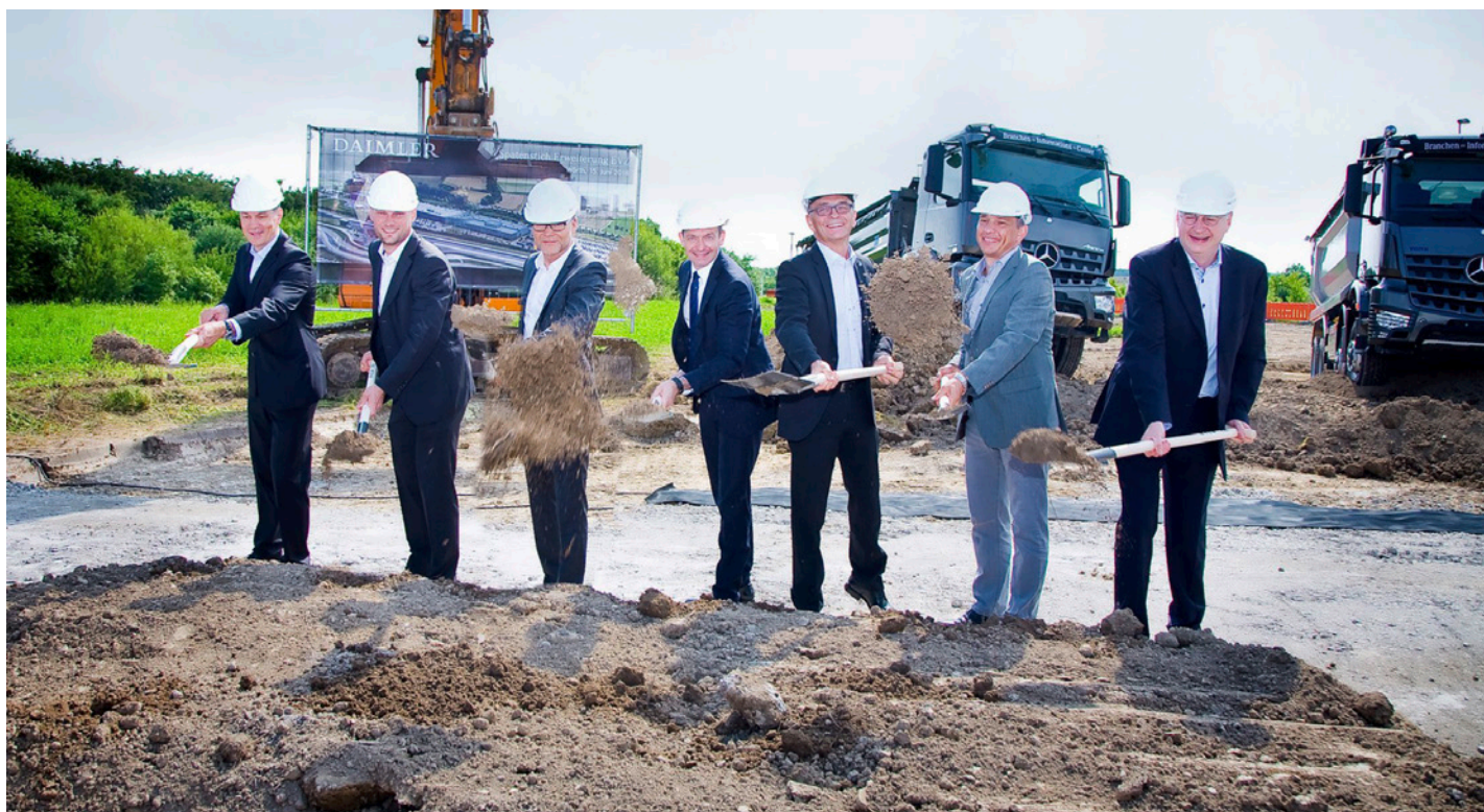
Spatenstich zur Erweiterung des EVZ (von links: Hr. Dr. Ettischer, Hr. Nitsche, Hr. Prof. Dr. Baake, Hr. Dr. Wissing, Hr. Dr. Brechtel, Hr. Zwick, Hr. Jank)
