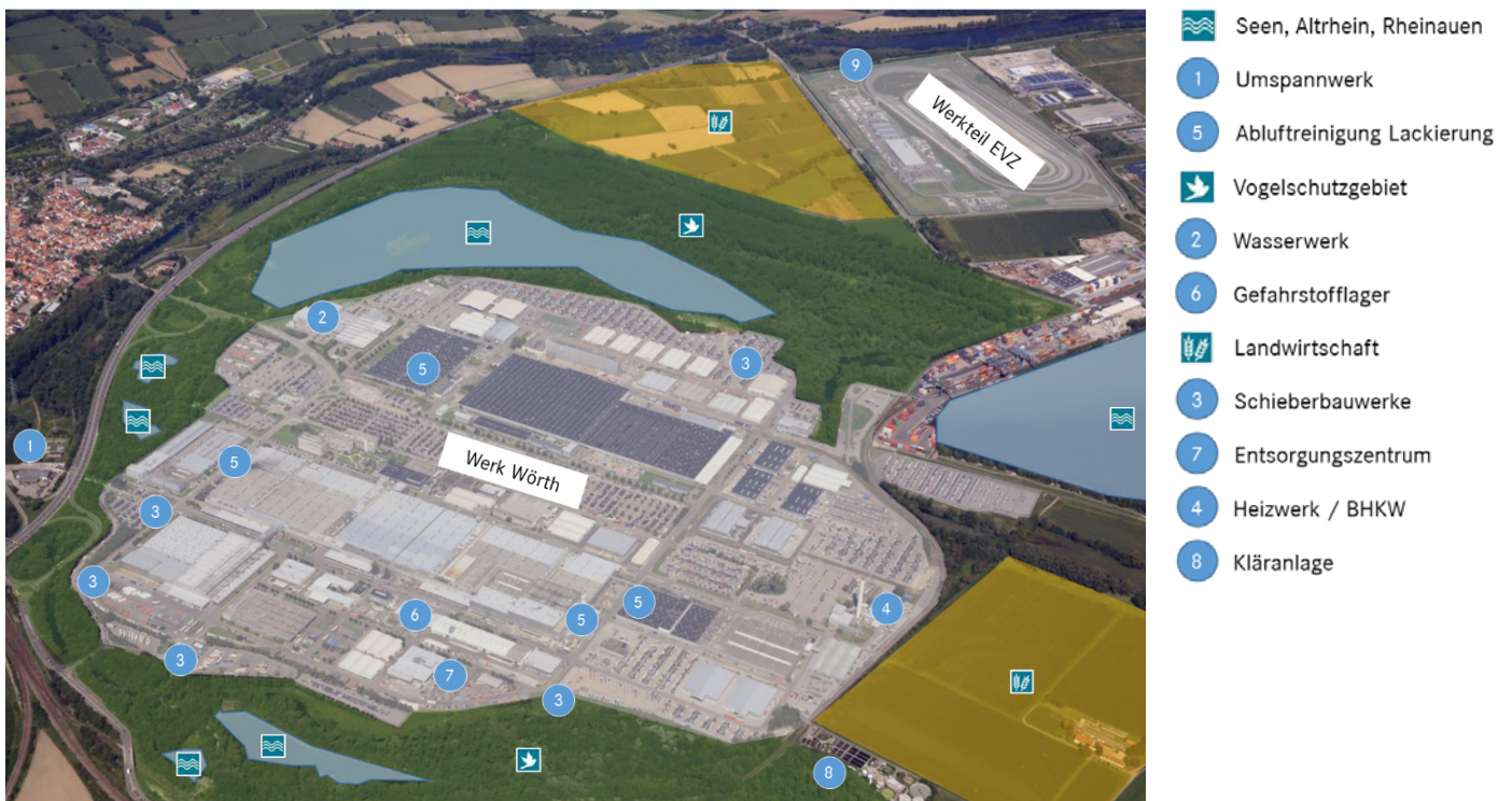
Abb. 1: Wesentliche umweltrelevante Anlagen des Standort Wörth
