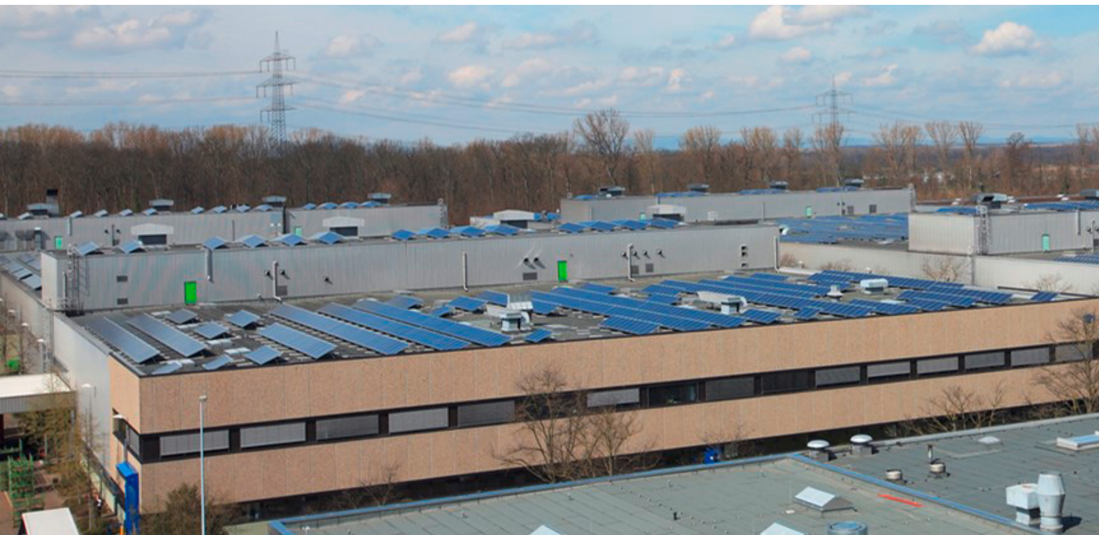
Photovoltaik-Anlage auf Dächern am Standort Rastatt
