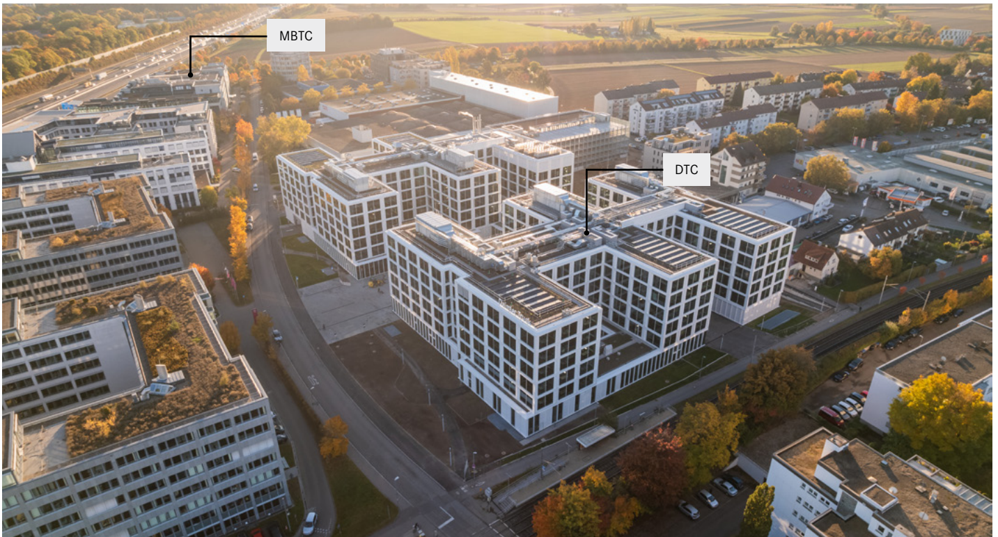
Abb.: Standort Leinfelden-Echterdingen mit den Gebäuden Mercedes-Benz Trucks Campus und Daimler Truck Campus
